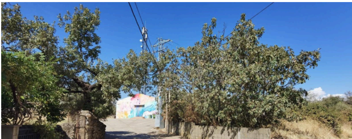
Línea eléctrica de media tensión y antena de telecomunicaciones al final de la calle las Viñas.
